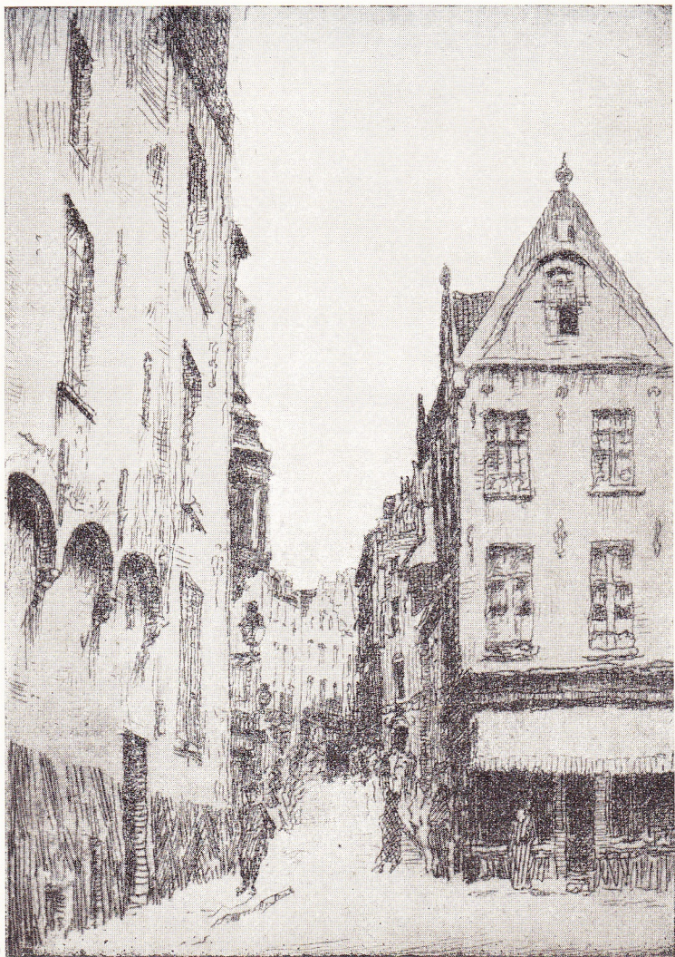
Rue de Rollebeek en 1928, vue de la rue des Alexiens : le pignon de gauche, démoli en 1937, lors des travaux de la jonction.
